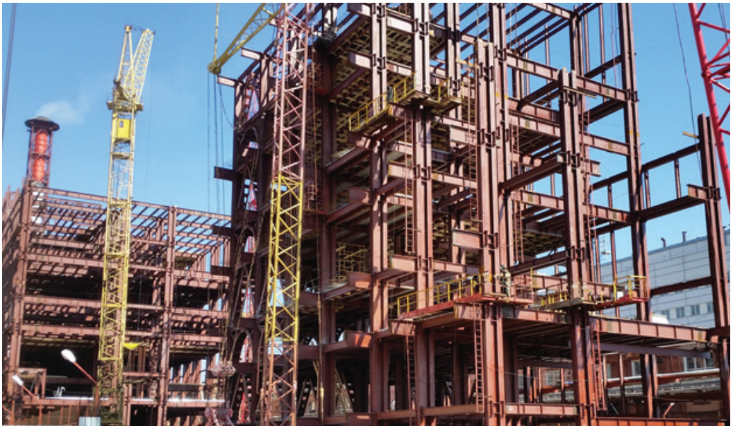
Рисунок 2. Строительство корпуса аффинажного производства ОАО «Красцветмет»
