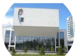
**Москва - ЖК «Скай Форт»** (ограждающие конструкции серии ЭК-640 предназначены для остекления неотапливаемых помещений жилых и общественных зданий и служат для защиты от внешних атмосферных воздействий и улучшают теплоизоляцию внутренних помещений).
